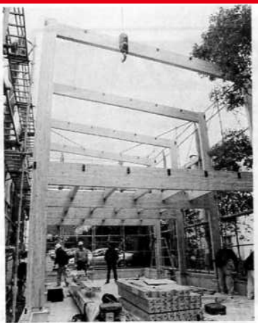
門型ラーメンフレーム&HSS金物工法の実験室
